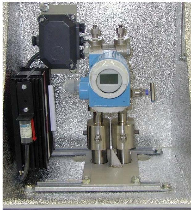
**Монтаж на расстоянии: Проверенная технология**
